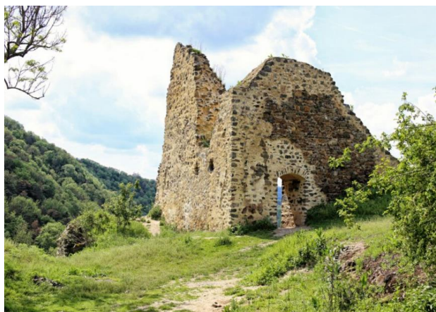
Obr.36 Velká obytná věž od jihovýchodu
