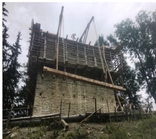
Obr.120 Stavba hranolové obytné věže
