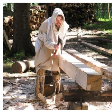
Obr.123 Tesání trámu sekerou
