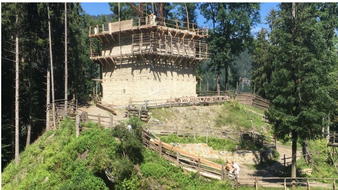
Obr.118 Stavba hranolové obytné věže
