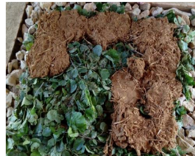
Obr.131 Těsnění klenby
