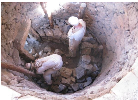
Obr.138 Stavba vápencové vrstvy
