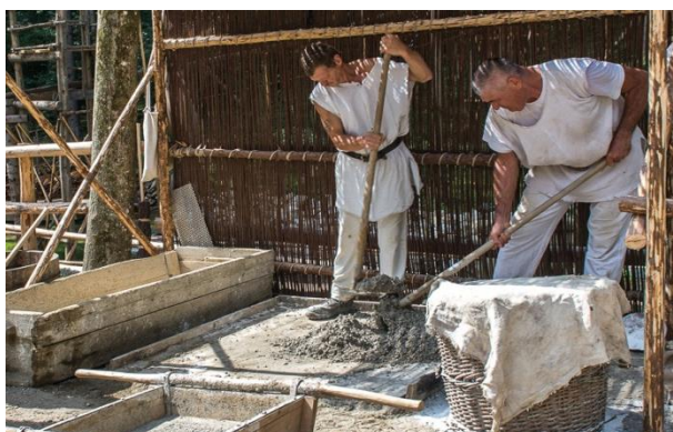
Obr.139 Míchání vápenné malty
