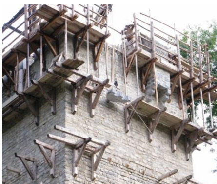
Obr.121 Stavba obytné věže
