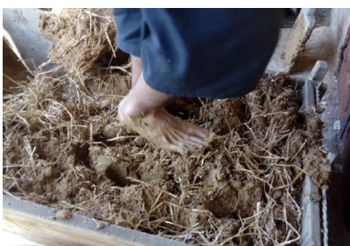
Obr.132 Příprava těsnicí hmoty
