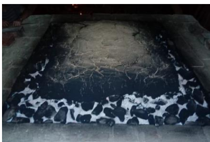
Obr.135 Klenba po výpalu
