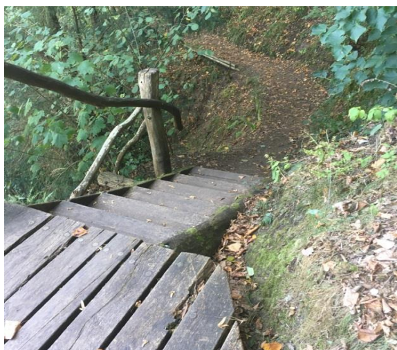
Obr.25 Schody na stezce nad Berounkou
