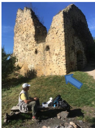
Obr.33 Dron ve vzduchu (šipka)
