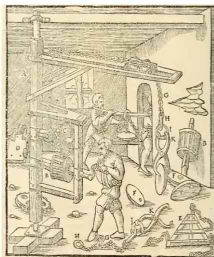
Obr.7 Hutní jeřáb s vrátkem
