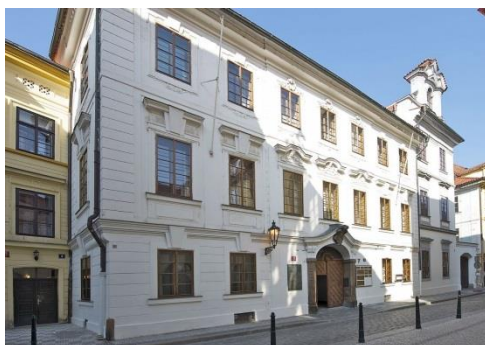
Obr.414 Budova č.5 v Husově ulici nyní
