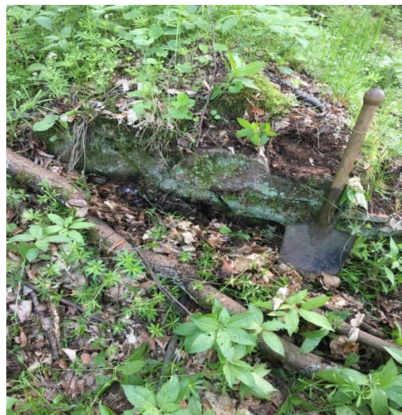
Obr.92 Rozvaliny základů čp.186 (Obr.86)
