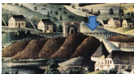
Obr.79 Rampy s dráhou pro vozíky
