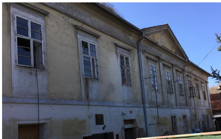
Obr.267 Nižbor - budova náležející někdejší železárnám
