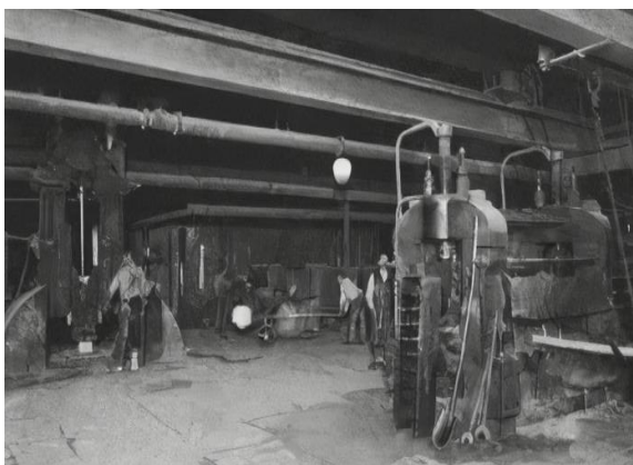
Obr.481 Pudlovací pec – celkový pohled
