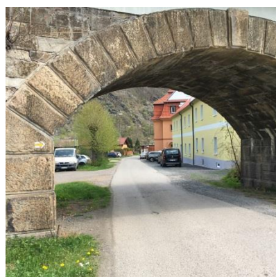
Obr.238 Železniční viadukt z r.1876
