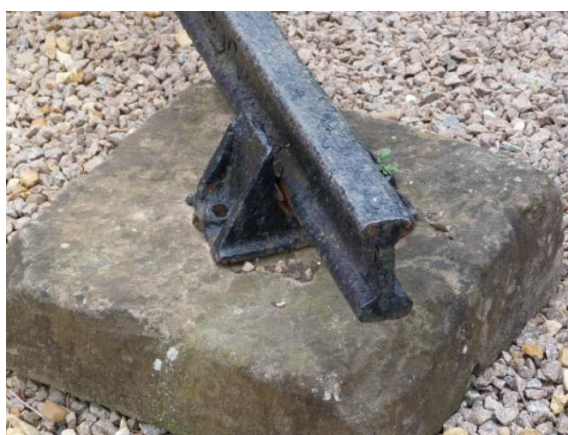
Obr.153 Upevnění stoličky na kvádr
