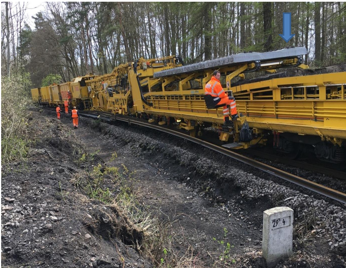
Obr. 495 Stroj provádějící výměnu pražců a výměnu kolejnic
