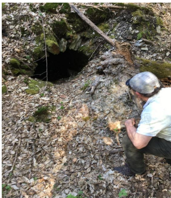
Obr. 135 Propust pod kamenným náspem
