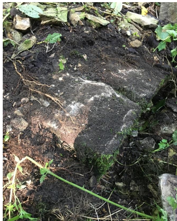
Obr. 247 Zbytky opěry mostu přes náhon
