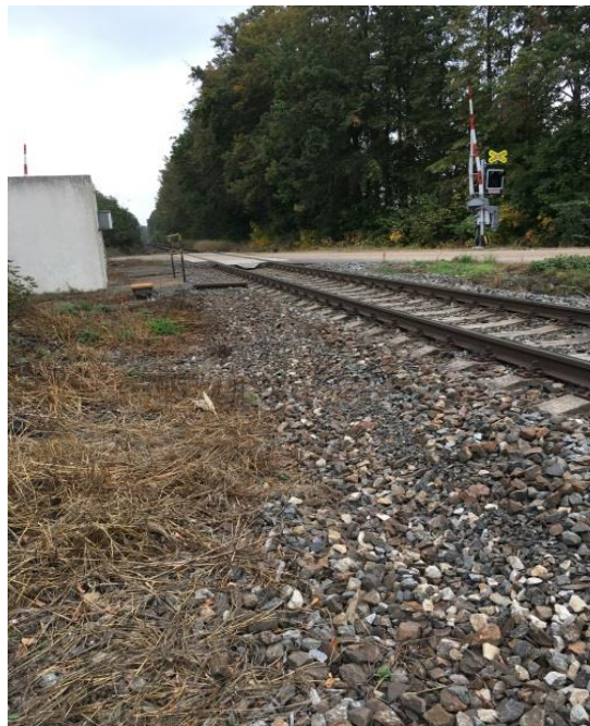
Obr.437 Křížení dráhy a Karlovarské silnice
