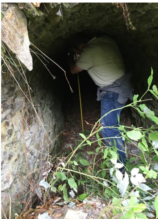
Obr.138 Současná výška klenby je cca 1,55 m
