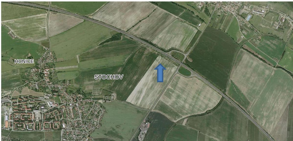
Obr.224 Letecký snímek mimoúrovňové křižovatky dálnice D6/E48 se silnicí 236 (Lány- Smečno)
