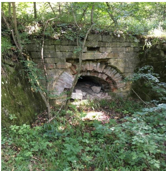
Obr. 290 Pohled do propusti od jihu
