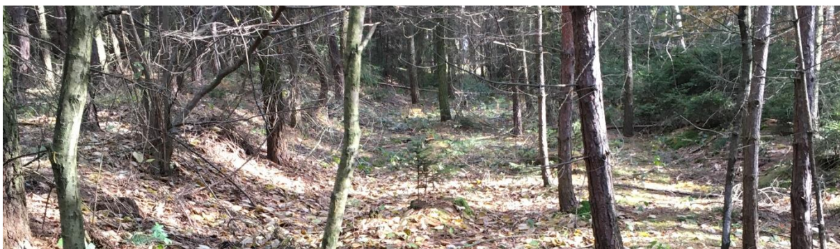
Obr.355 Pohled na zarostlou trasu koněspřežné železnice, vzadu již prosvítá okraj lesa
