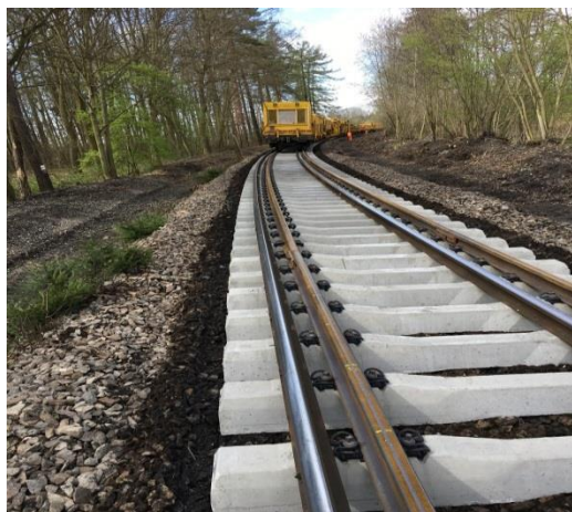
Obr.488 Vlevo stará kolejnice, vpravo nová
