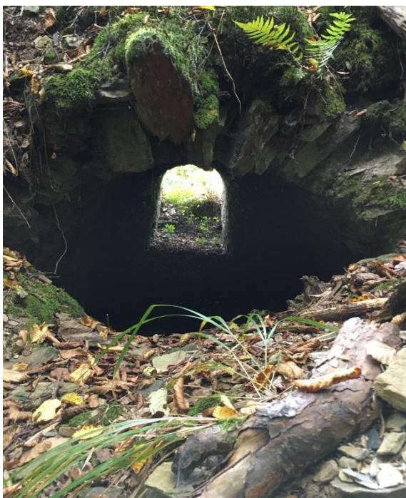
Obr.136 Pohled do propusti o šířce asi 1,2 m
