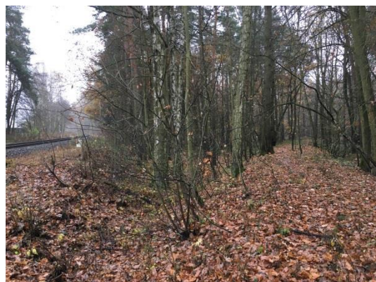
Obr.404 Oblouk náspu zrušené železnice
