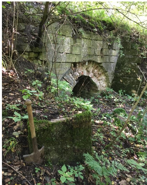
Obr. 286 Pohled do propusti od severu
