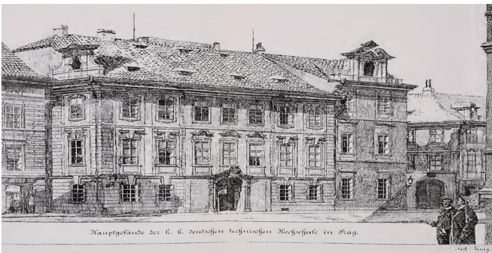
Obr. 473 Budova Polytechnického institutu v nynější Husově ul. č.5 v Praze 1 (Lit.68)
