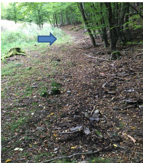
Obr. 134 Mokvající svah nad propustí
