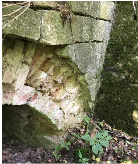
Obr.284 Propust od severu
