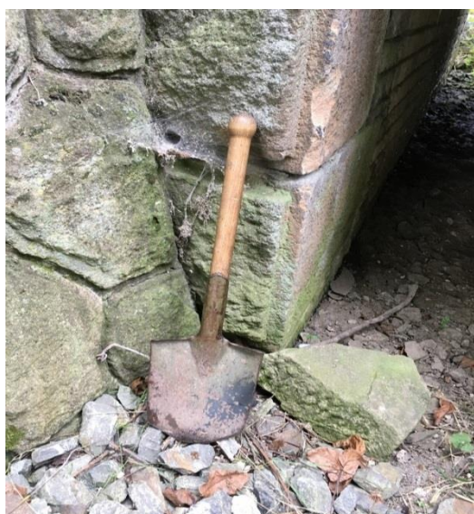
Obr.449 Kyklopské kamenné zdivo
