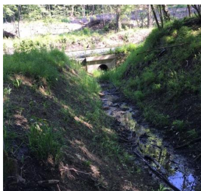
Obr. 338 Nová propust pod tratí
