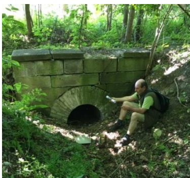
Obr.275 Propust u skladu
