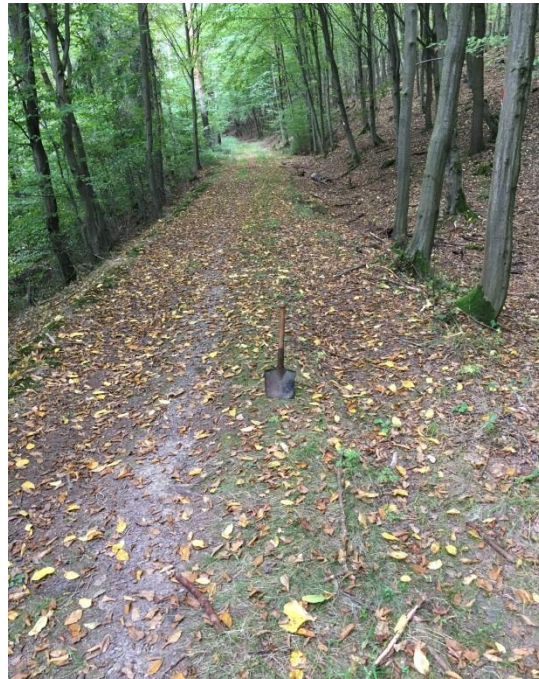
Obr.129 Zářez a násep ve svahu
