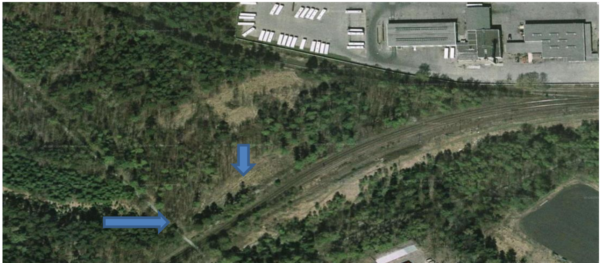
Obr.400 Nádraží Kladno – trasa koněspřežné železnice v zářezu o šíři cca 4,5 m – snímek z roku 2006
