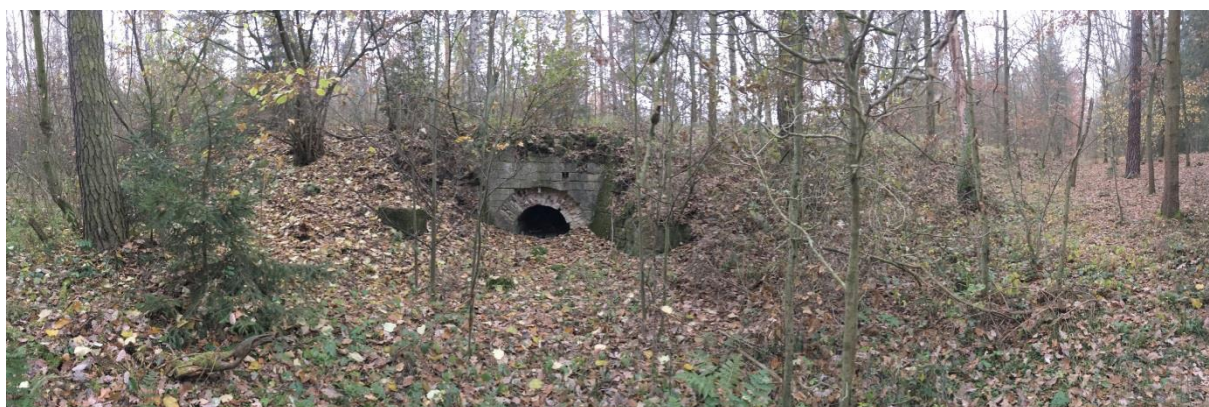
Obr.280 Propust v náspu koněspřežky položená severně od současné železnice, pohled od severu
