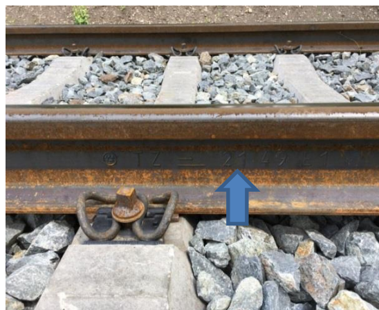
Obr. 490 Stav svršku po podbití štěrskem
