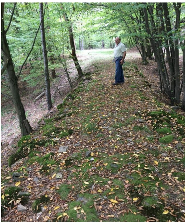
Obr.132 Na sucho kladený kamenný náspe
