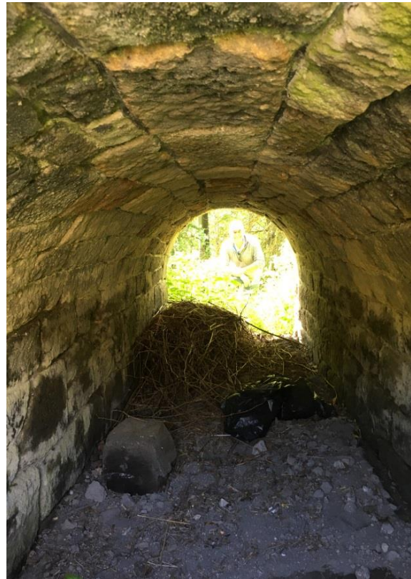
Obr. 211 Kamenná klenba propusti v náspu
