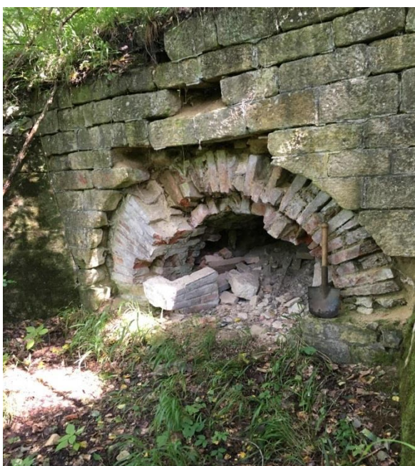
Obr.288 Pohled na propust od jihu
