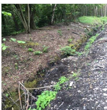
Obr.339,340 Odvodňovací příkop mezi násypy koňky a železnice
