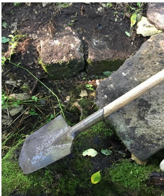
Obr.245 Zbytky západní opěry mostu přes náhon
