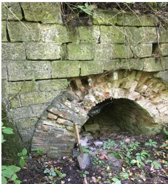
Obr.281,282 Propust v náspu koněspřežky cca 300 metrů západně od silničního přejezdu u železniční stanice Kamenné Žehrovice. Souřadnice propusti jsou 50^{\circ}08'30.9540'' N 14^{\circ}01'50.8050'' E , snímky jsou z konce léta 2021. Šířka propusti je cca 1,2 metru. Délka polní lopatky je 60 cm, šířka 16 cm. Délka rozvinutého pásma je 2 metry.
