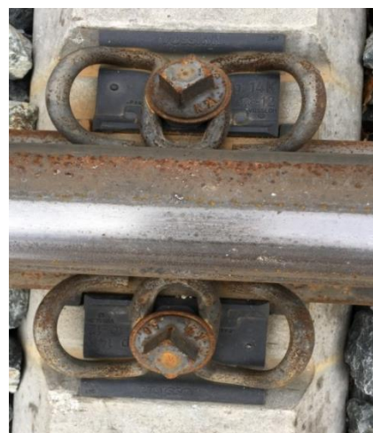
Obr.492 Upevnění kolejnice
