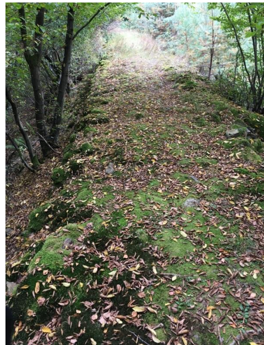
Obr.131 Na sucho kladený kamenný násep
