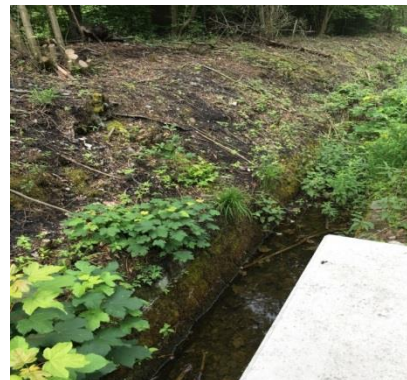
Obr. 338 Nová propust pod tratí Obr.339,340 Odvodňovací příkop mezi násypy koňky a železnice
