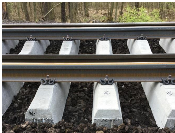
Obr.489 Detail kolejnic a upevnění k pražcům
