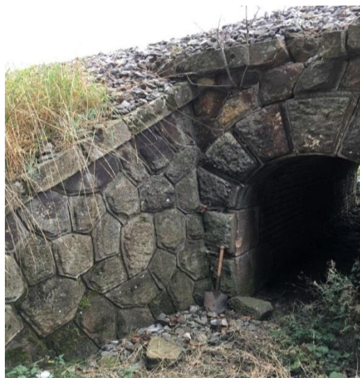
Obr. 448 Násep železnice u stanice Ruzyně
