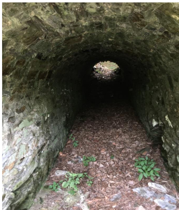
Obr.137 Propust o délce asi 6 metrů
