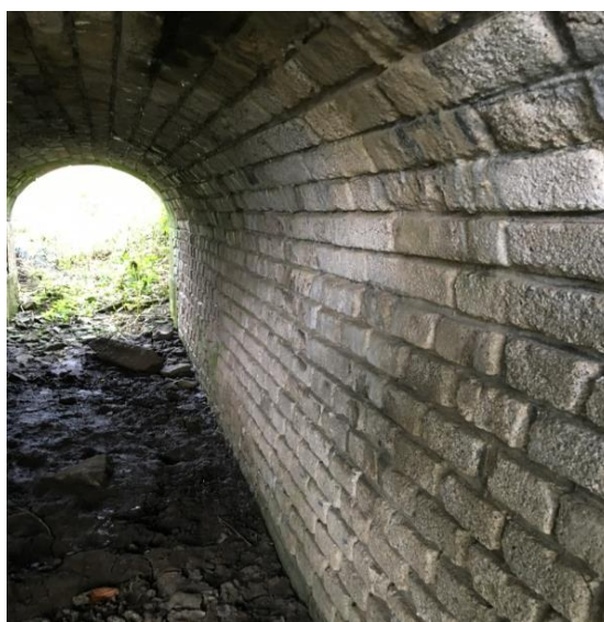
Obr.450 Cihlová klenba – šířka propusti je 110cm
