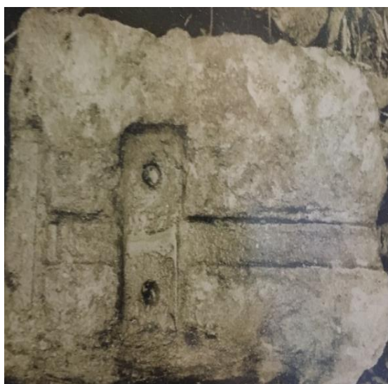
Obr.43 Otvory po dřevěných hřebech
