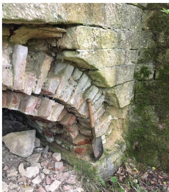
Obr.289 Pohled na propust od jihu
