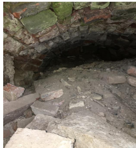
Obr.291 Detail klenby propusti od jihu
