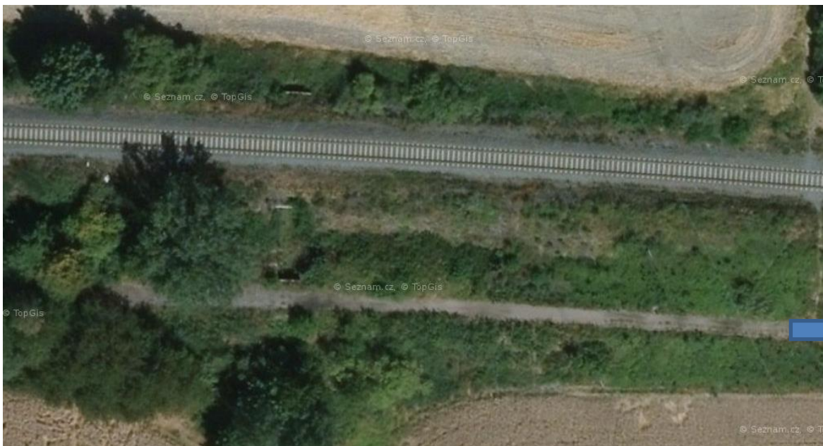
Obr.212 Trasa koněspřežné železnice s propustí jižně od současné železnice, snímek je z r.2006
