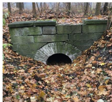
Obr.277 Propust u skladu
