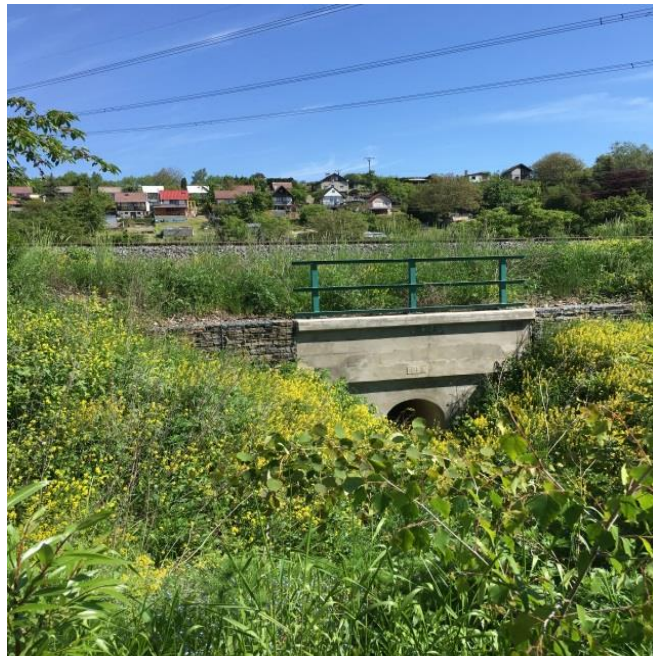
Obr.209 Modernizovaná propust pod současnou tratí
