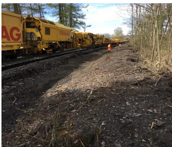
Obr.485 Souprava pro výměnu pražců
