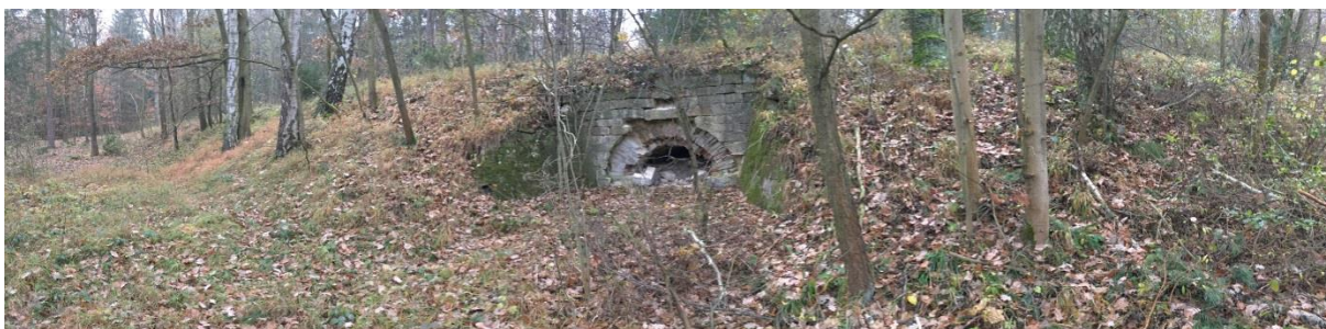
Obr.287 Pohled na násyp u propusti od jihu
