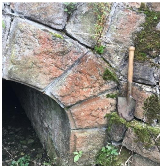
Obr.447 Propust v polích u stanice Ruzyně
