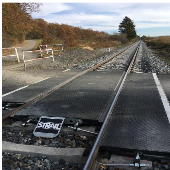
Obr.499 Železniční trať po rekonstrukci
