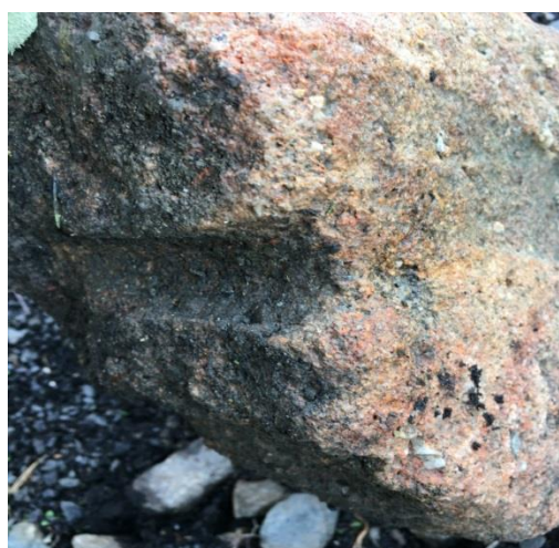
Obr. 337 Otvor pro dřevěný hřeb stoličky
