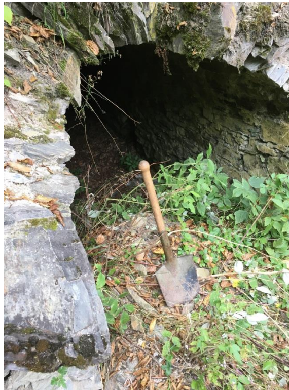
Obr.139 Vyústění propusti – lopatka o délce 60cm
