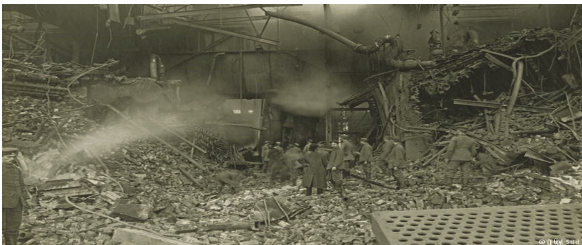
Obr.381 Parní kotelná pivovrau po výbuchu parního kotle
