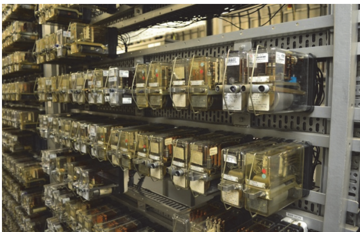
Obr.79 Elektropneumatické převodníky v panelu
