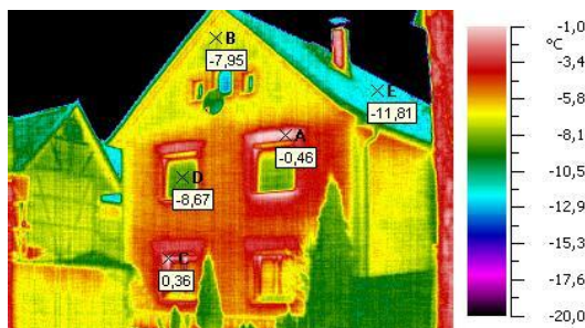
Obr.635 Termovizní snímek budovy
