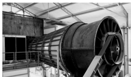
Obr.218 Aerodynamický tunel (r.1910)
