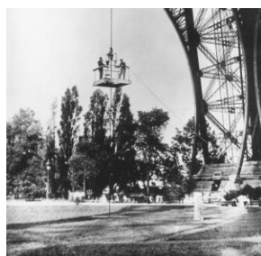
Obr.429 Plošina u věže
