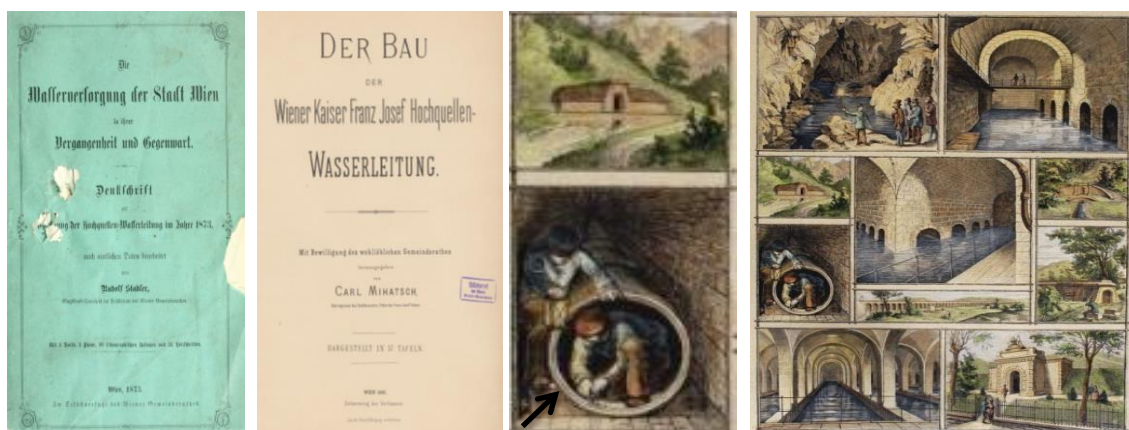
Obr.109 Titul Lit.14 Obr.110 Titul Lit.25 Obr.111,112 Potrubí položené pod zemí a vodojemy
