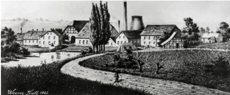
Obr.192 Hut' sv. Antonína- St. Antony Hütte v obci Oberhausen
