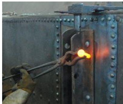
Obr.306 Vkládání nýtu do otvoru
