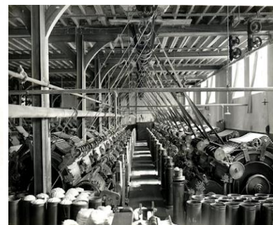
Obr.356 Mykací stroj
