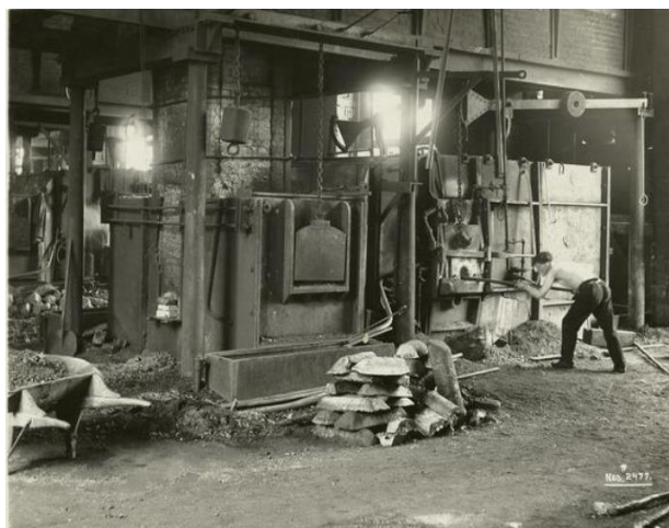
Obr.248 Surové železo v houskách u pudlovací pece
