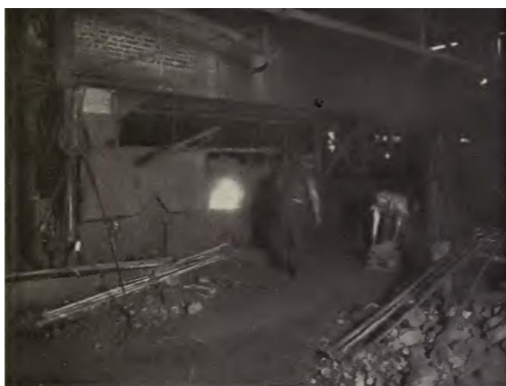
Obr.245 Práce u pudlovací pece
