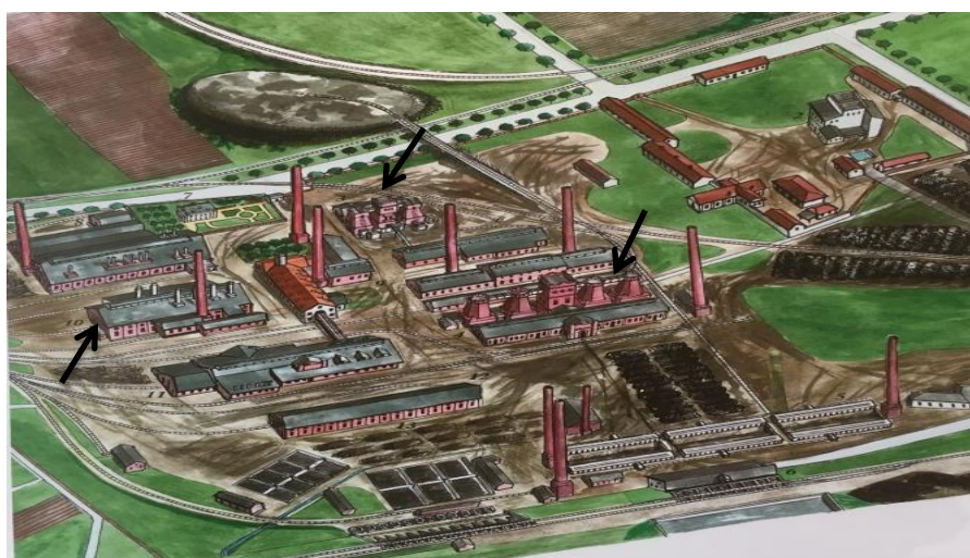
Obr.41 Pohled na provozy Pražské železářské společnosti od jihu
