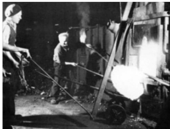
Obr.258 Pokládání kusu železa na vozík
