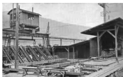
Obr.217 Dopravní a chladicí zařízení
