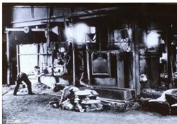
Obr.246 Práce u pudlovací pece
