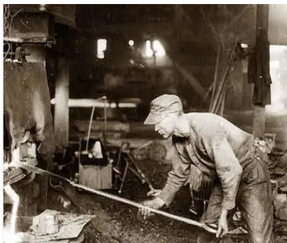
Obr.247 Vypouštění strusky z pudlovací pece
