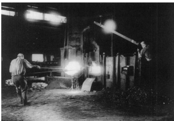
Obr.259 Vyjímání kujného železa z pece
