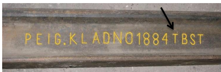
Obr.241 Nosník vyrobený v Pražské železářské společnosti
