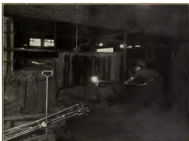
Obr.250 Práce u pudlovací pece
