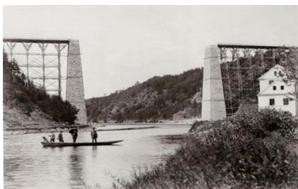
Obr.119 Montáž mostu roku 1889
