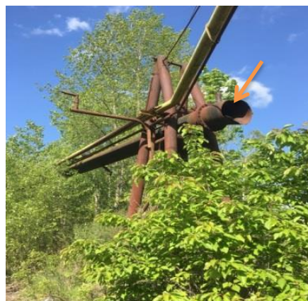
Obr.67 Potrubí generátorového plynu
