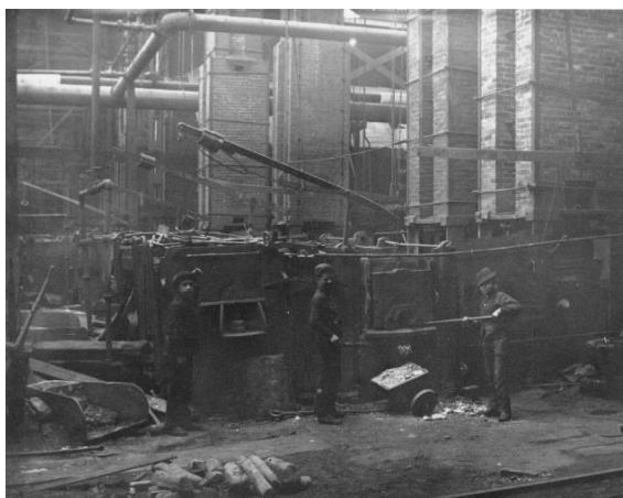
Obr.249 Vypouštění strusky do ručního vozíku
