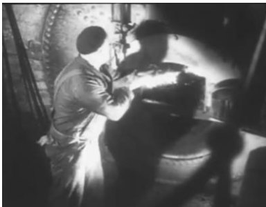
Obr.82 Topič u parního kotle
