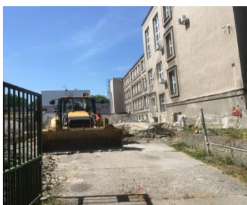
Obr.10 Zadní průčelí budovy
