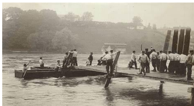
Obr.193 Sestavování pevných podpor mostu
